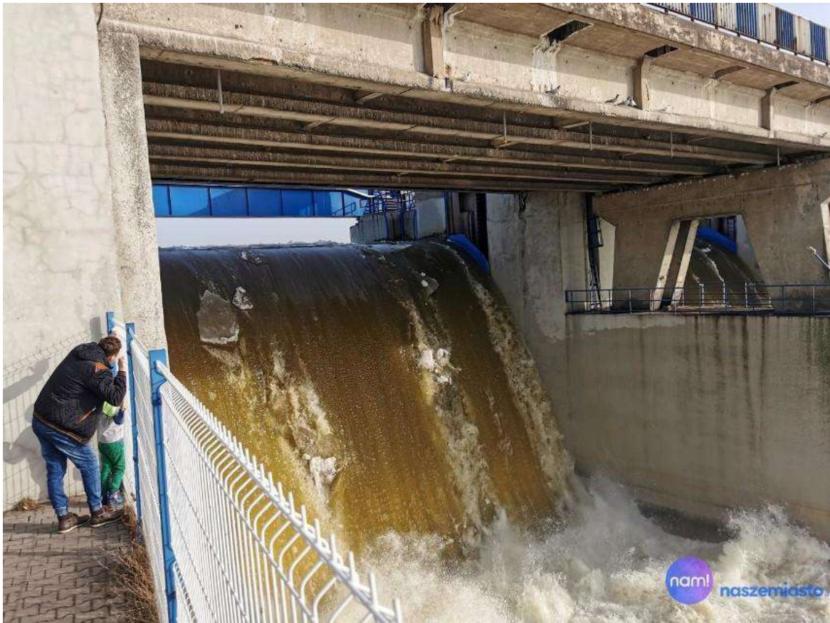
Spust wody jednym z 10 przęseł.
