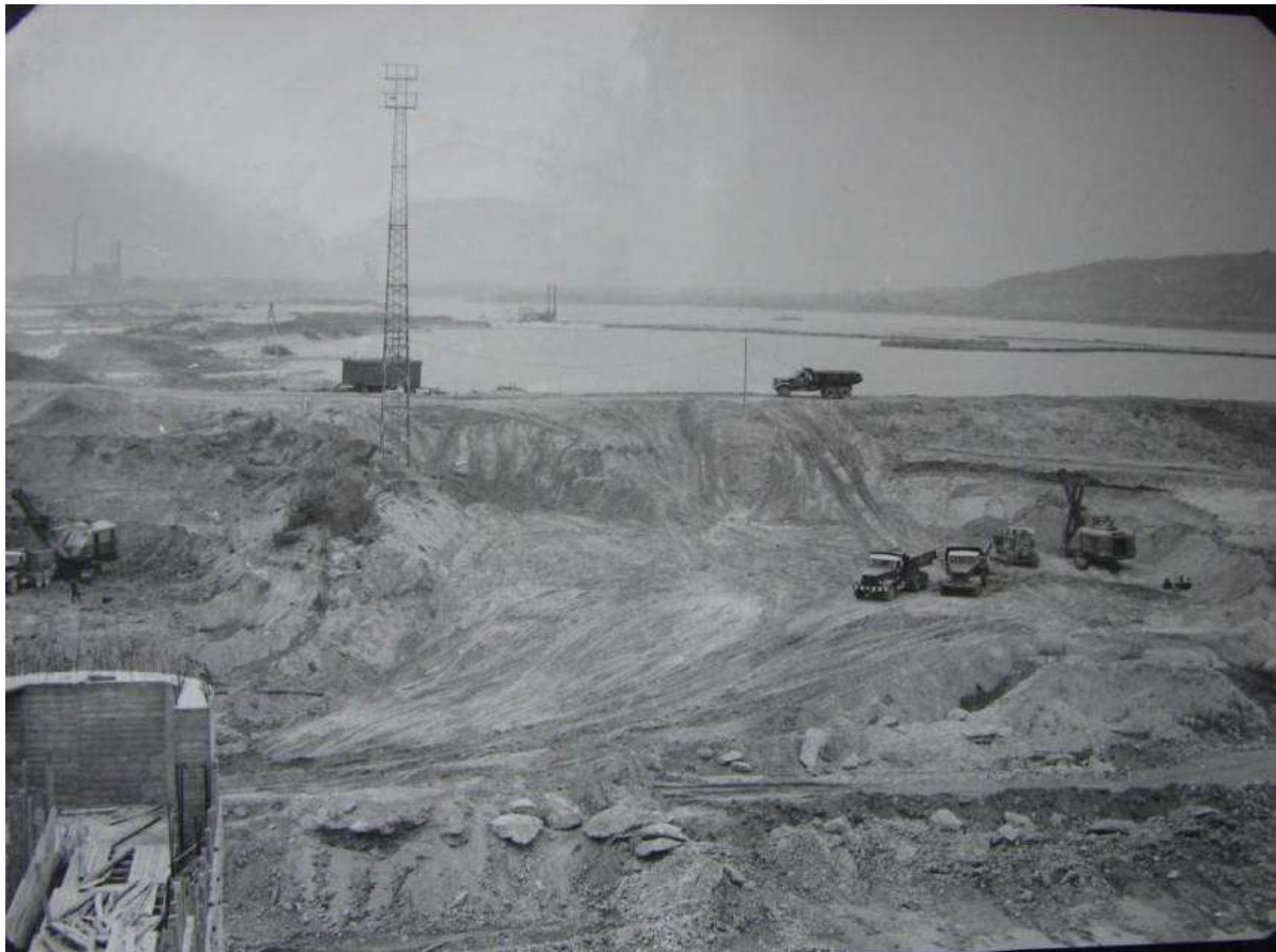
Roboty ziemne 1966 rok.
