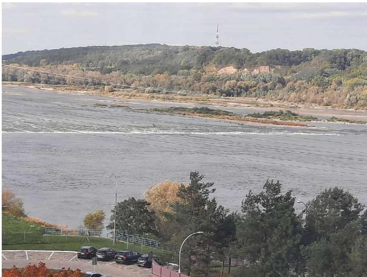
Próg faszynowo – kamienny poniżej stopnia wodnego.
