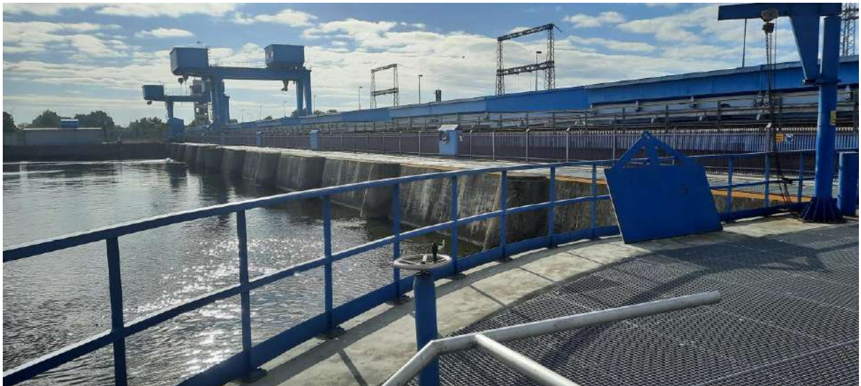
Widok na elektrownię z przepławki.
