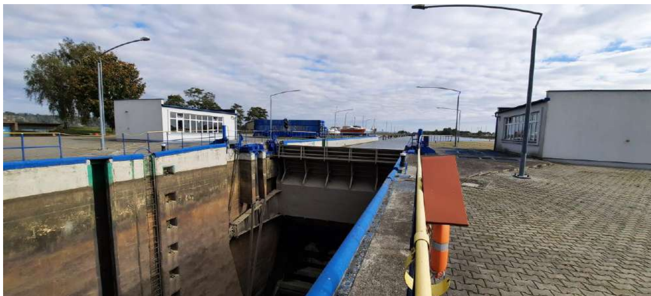
Zamknięcie sluzy od wody górnej.
