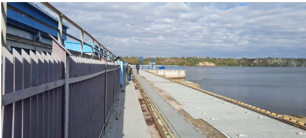
Poziom 60,00 dach elektrowni.
